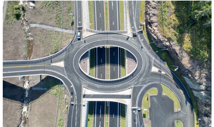
Denne rundkjøringen er på nordsiden av Sollihøgdatunnelen. Foto: Oliver Hinchey/Statens vegvesen
