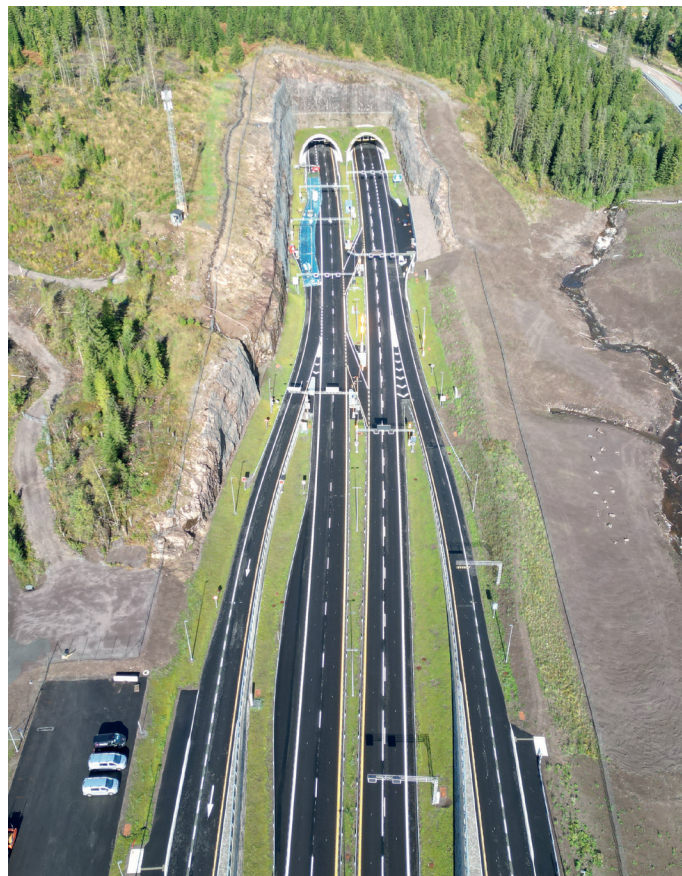
Den sørlige åpningen til Bukkesteinhøgdtunnelen, som har en lengde på 700 meter. Foto: Oliver Hinchey/Statens vegvesen
