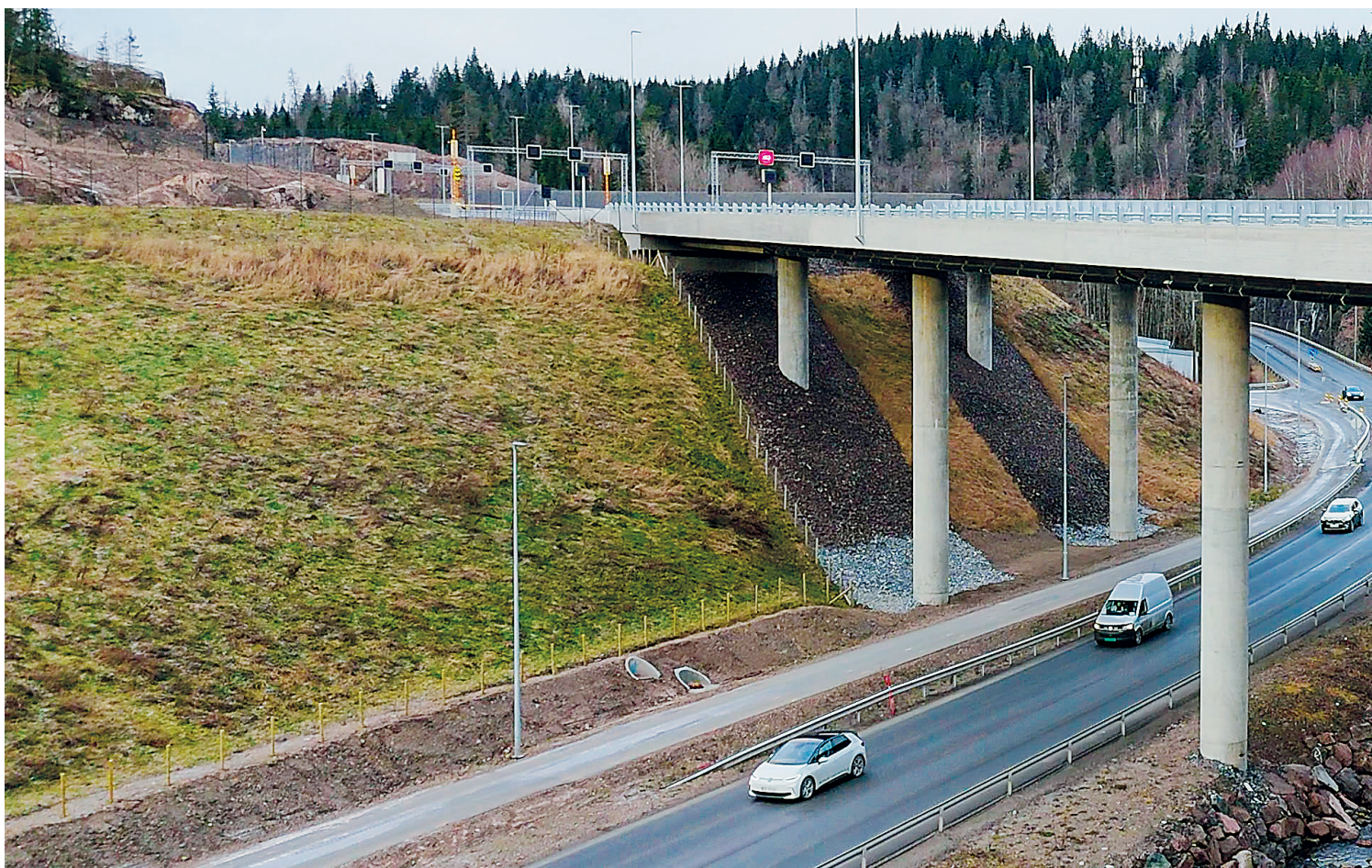
Da begge løp på Isielva bruer ble støpt, gikk det med hele 22.000 tonn betong.
